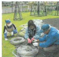
設置作業風景
