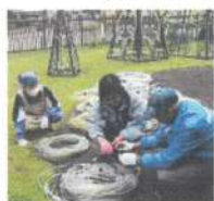
設置作業風景
