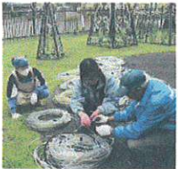
設置作業風景
